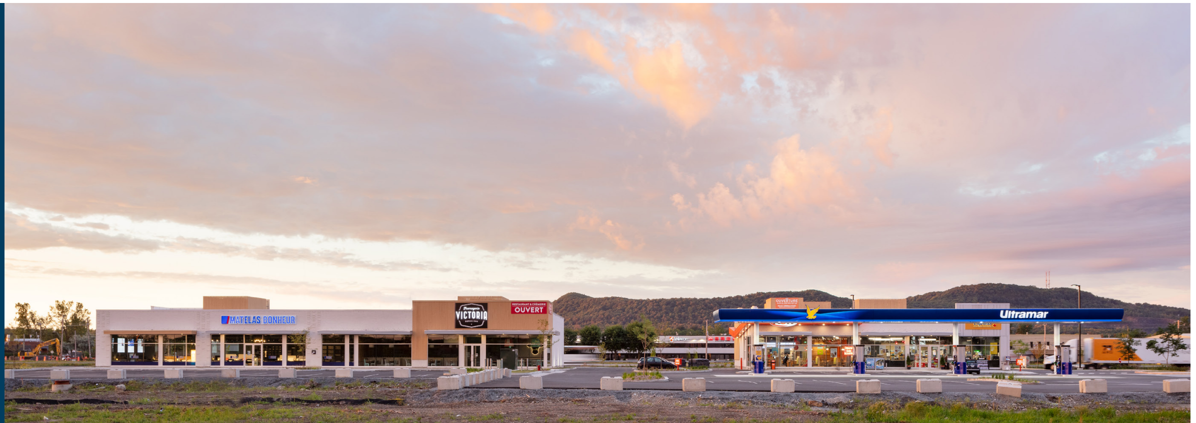
BÂTIMENT F - G
