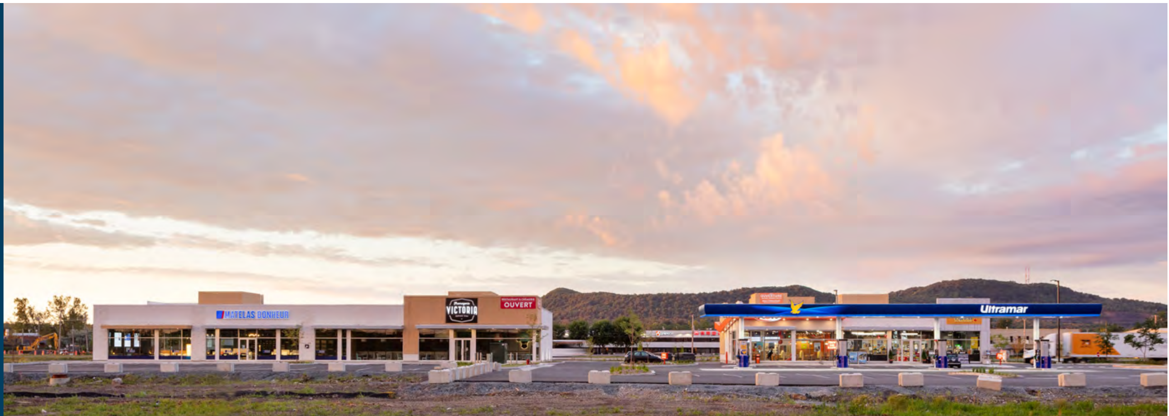
BÂTIMENT F - G
