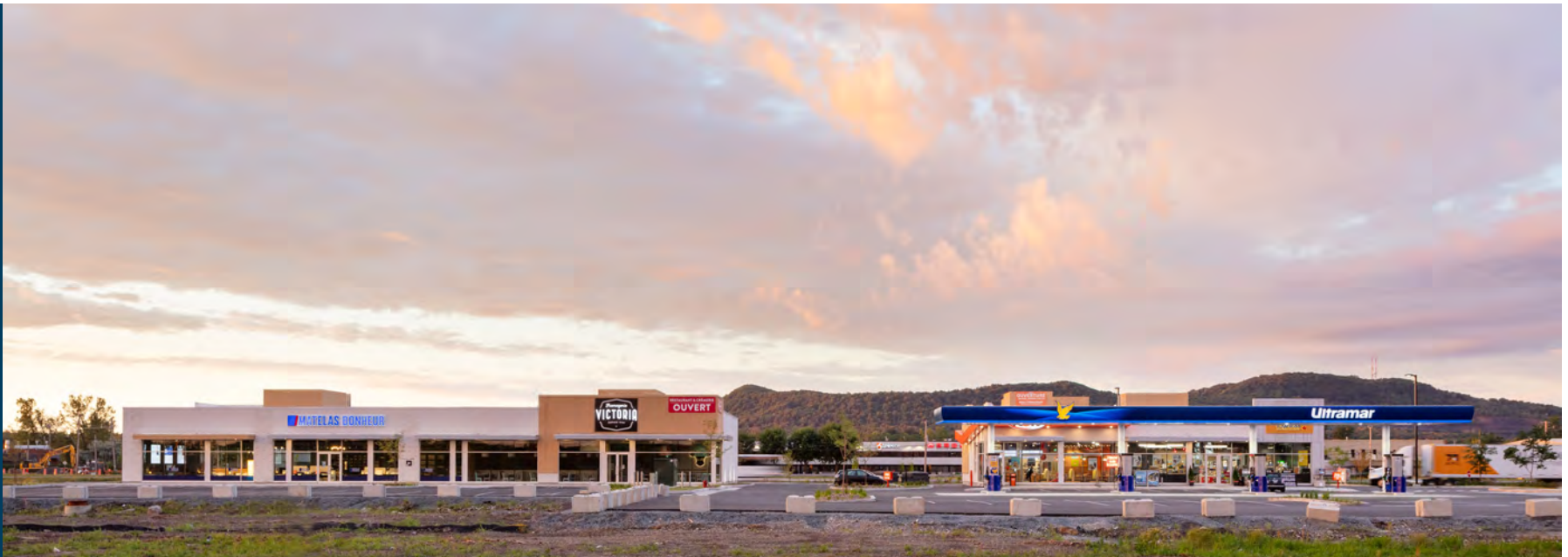
BÂTIMENT F - G
