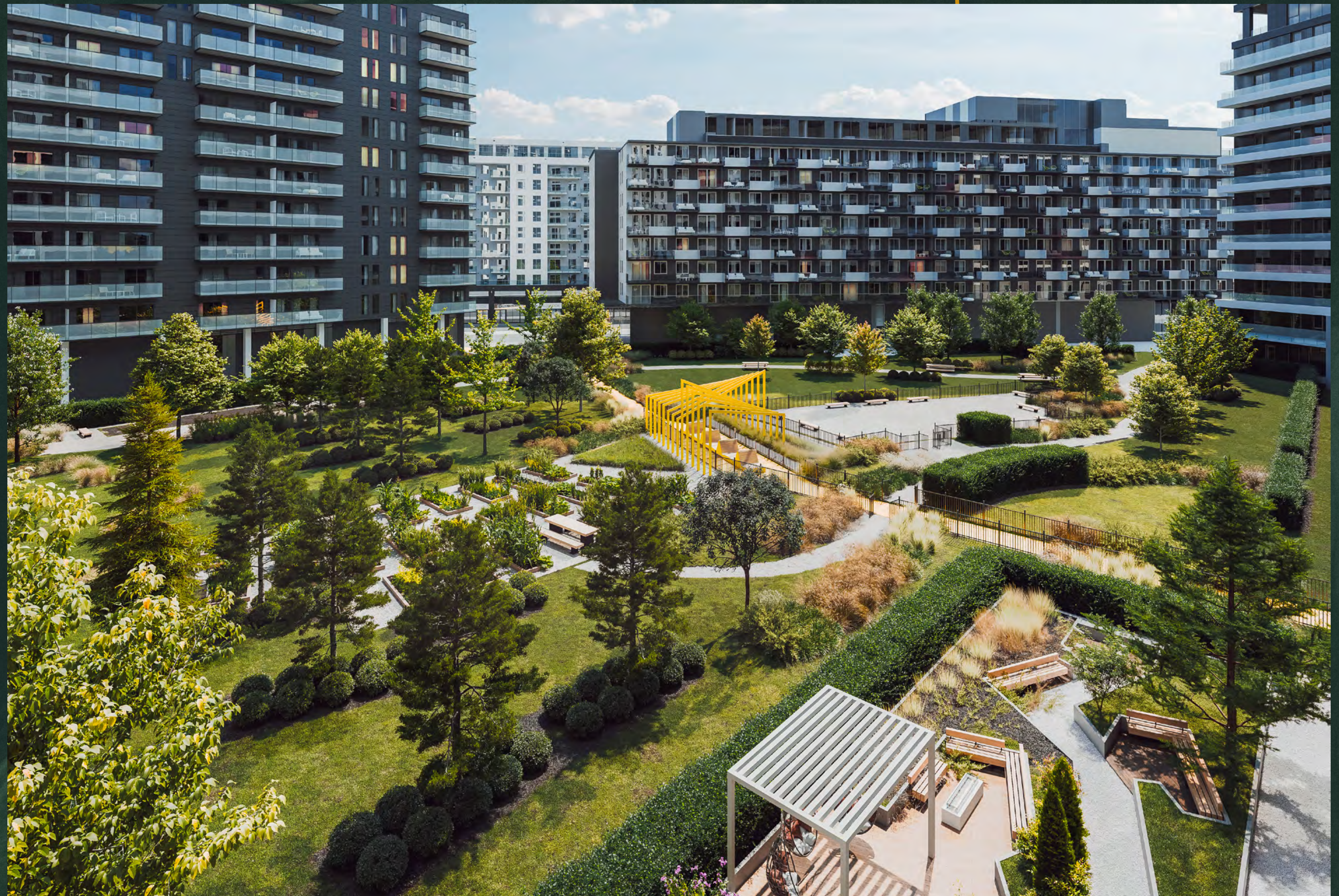
COUR PRIVÉE / PRIVATE COURTYARD
