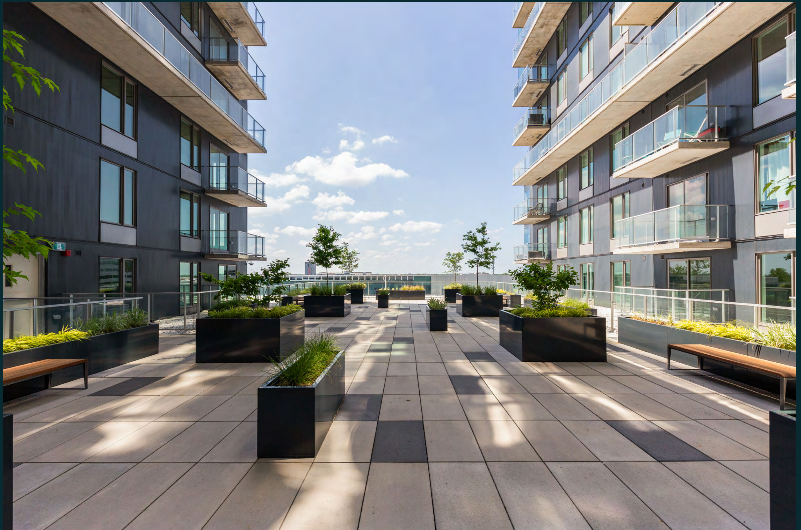
TERRASSE COUR INTÉRIEURE 3 E ÉTAGE / TERRACE INTERIOR COURTYARD 3 RD FLOOR
