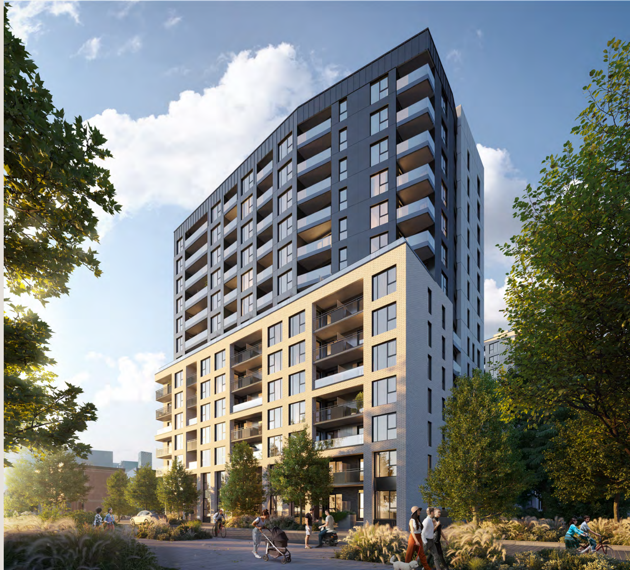
VUE DE LA RUE DE LA GAUCHETIÈRE / VIEW FROM DE LA GAUCHETIÈRE STREET
